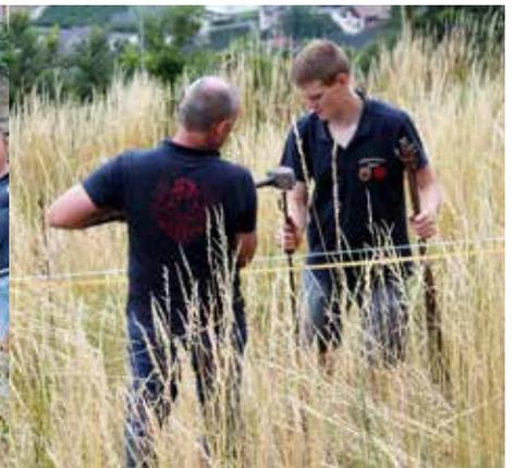
Das Kreuz wird eingemessen und die Betonstabstähle in den Boden gerammt.
